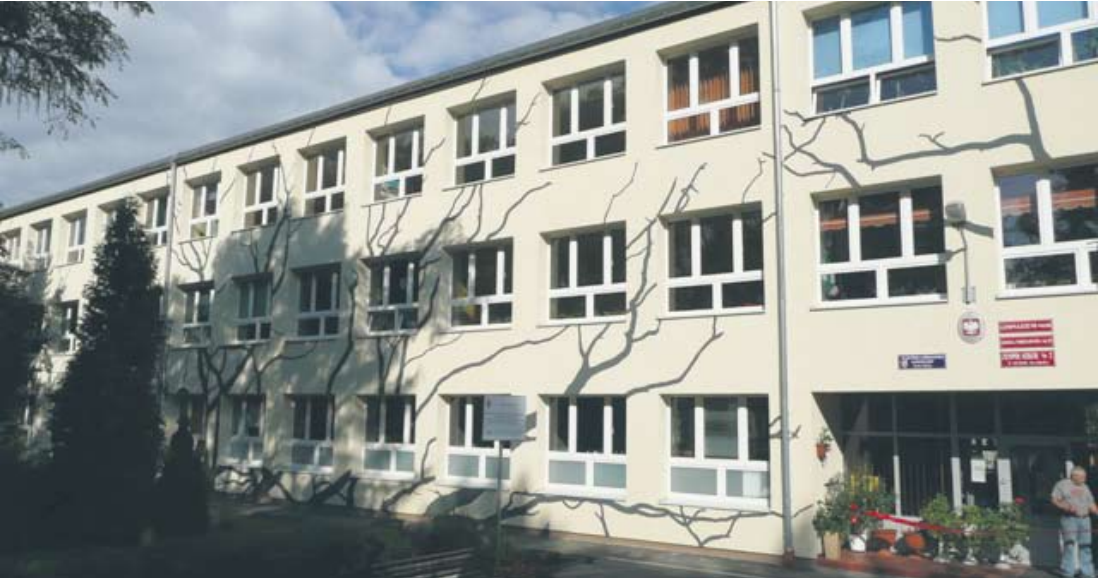
Szkoła przeszła generalny remont wraz z termomodernizacją za ponad 1,2 mln zł.
