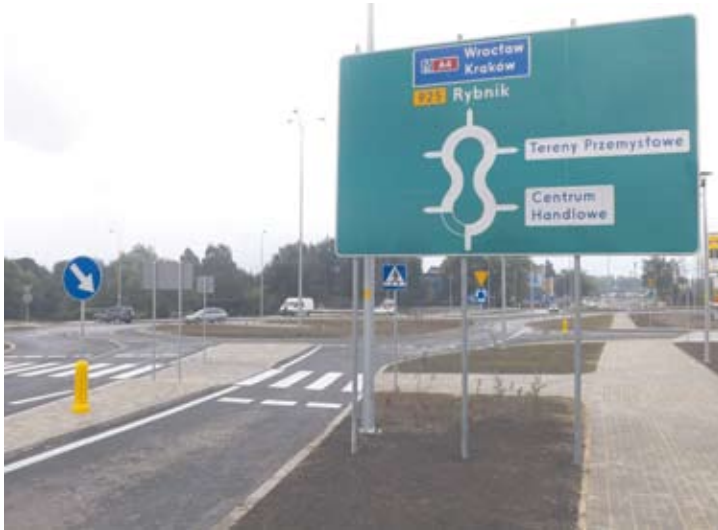
Najważniejszą częścią inwestycji była budowa dwóch rond turbinowych, które ułatwią wjazd na ulicę 1 Maja z ulic Klary i Szyb Walenty.
