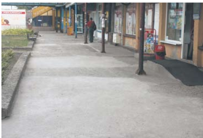
Chodnik po remoncie nie stanowi już zagrożenia dla przechodniów.
