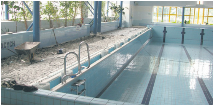
W ramach remontu skute i wypoziomowane zostaną plaże basenu.
