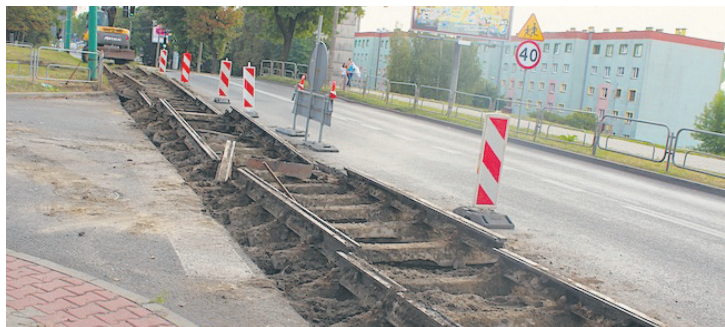
Prace na skrzyżowaniu już trwają.
