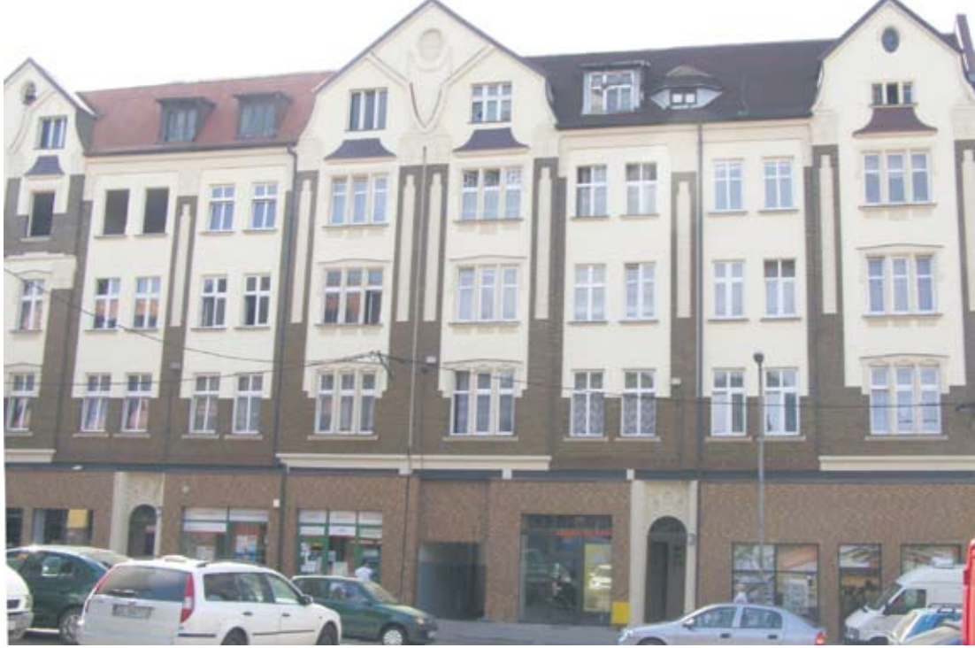
Renowacja kamienicy przy ul. Sienkiewicza to jedno z najważniejszych tegorocznych zadań z zakresu ochrony zabytków w mieście.
