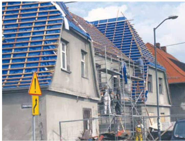
Obecnie trwa remont kamienicy przy ulicy Raciborskiej.
