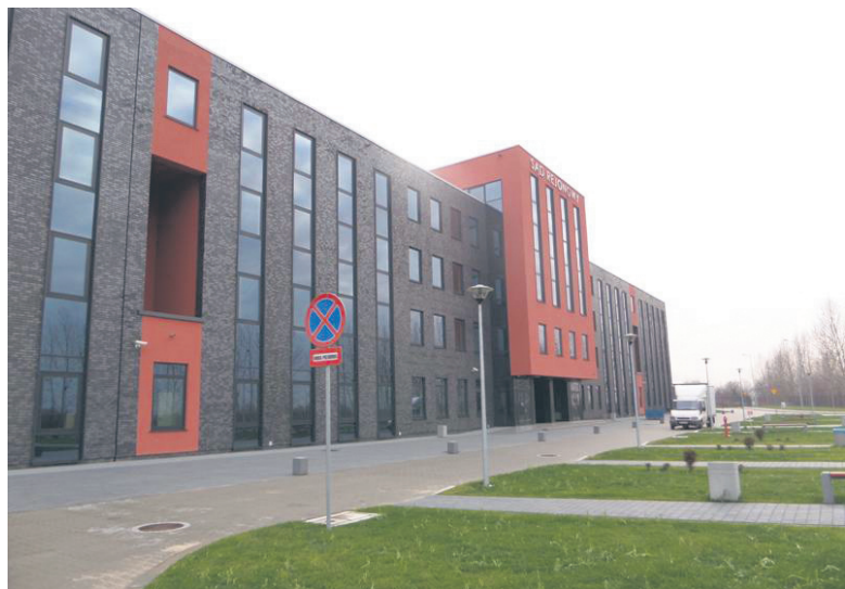
Nowy budynek Sądu Rejonowego w Rudzie Śląskiej praktycznie jest już gotowy.
