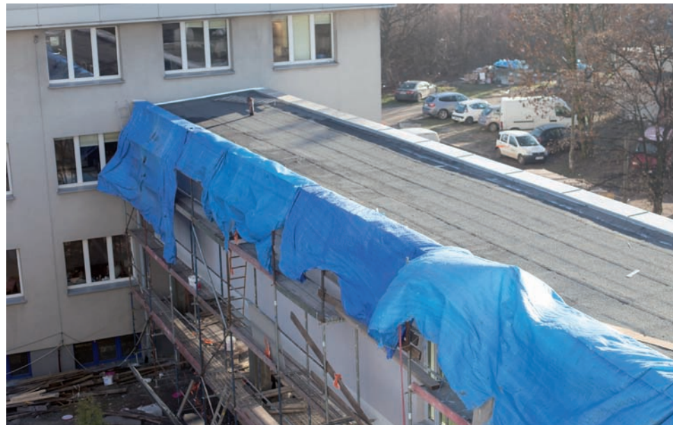
Obecnie trwa remont m.in. przejść pomiędzy budynkami.
